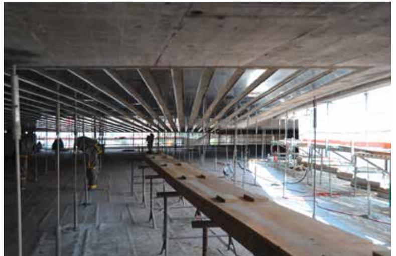
Carbonfaser verstärkte Kunststofflamellen (CFK Lamellen) als Massnahme zur Unterstützung der Statik
