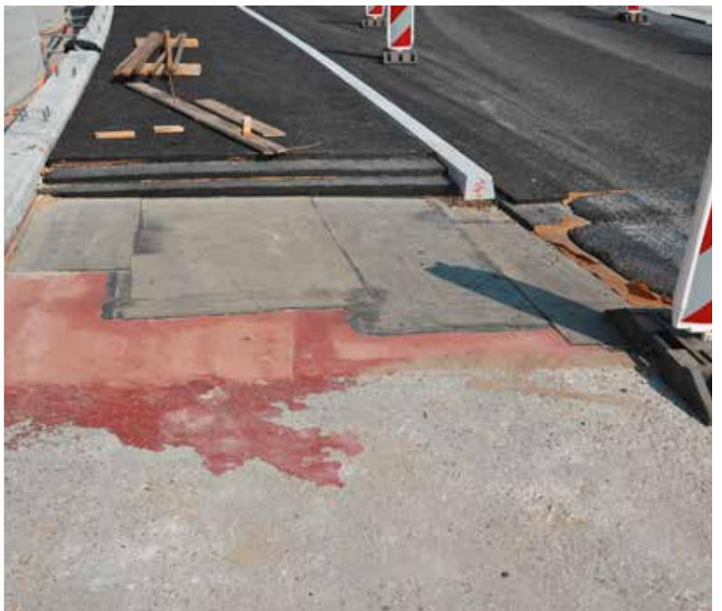
Fahrbahnaufbau (rote Versiegelung, Teerpappen, Gussasphalt)
