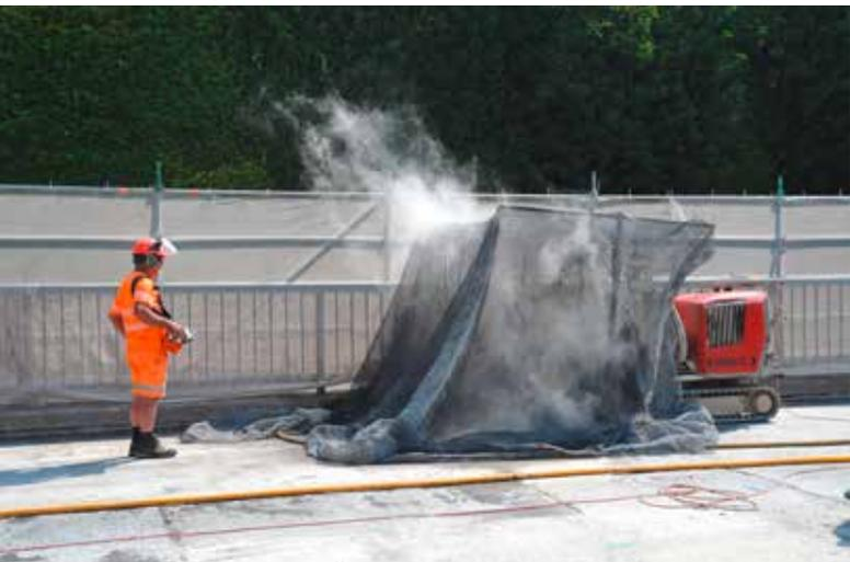
Hochdruckwasserstrahl-Arbeiten mit 5'000 Bar und Mithilfe eines Roboters
