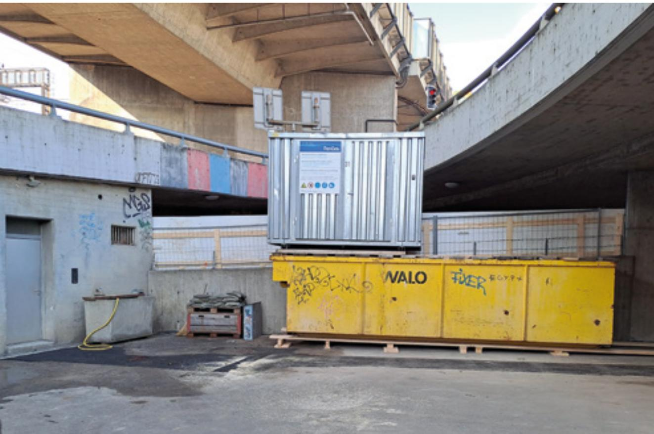
Absetzbecken mit aufgesetzter Begasungsanlage
