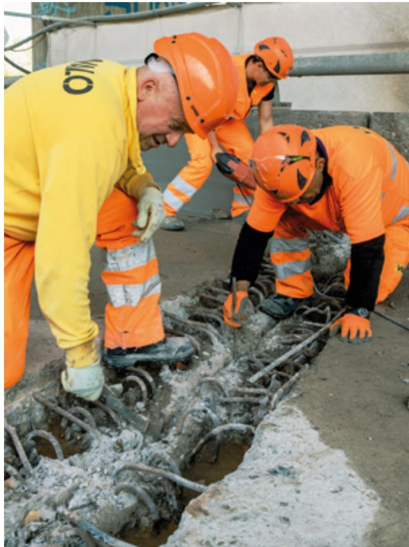
Korrosionsschäden am Fahrbahnübergang auf Höhe des Gerbergelenks werden behoben
