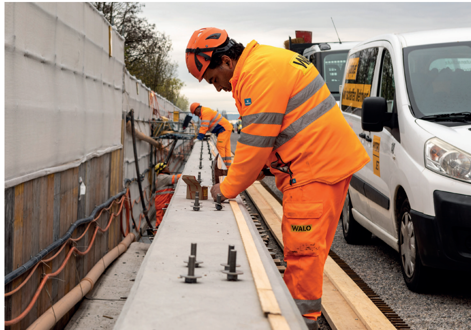
Für den Einbau des Strassenbelags wird die Abschalung vorbereitet.
