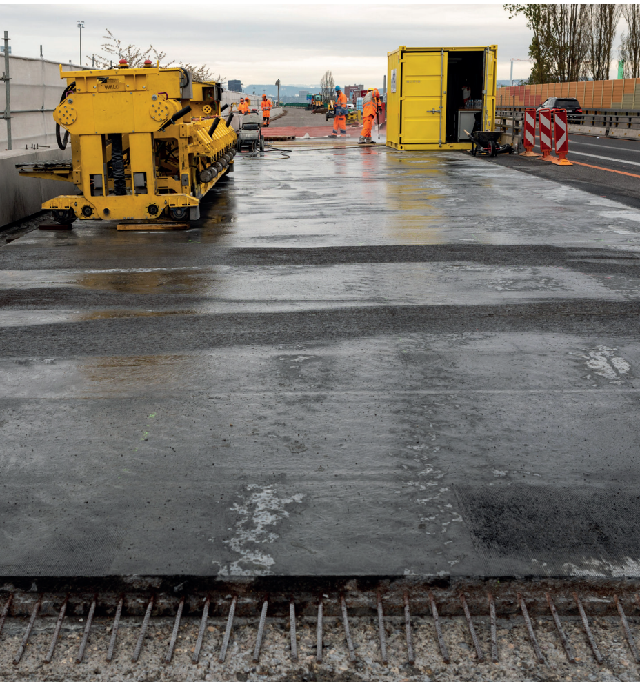
Neuer Strassenbelag (UHFB) für die Langsamfahrspur.
