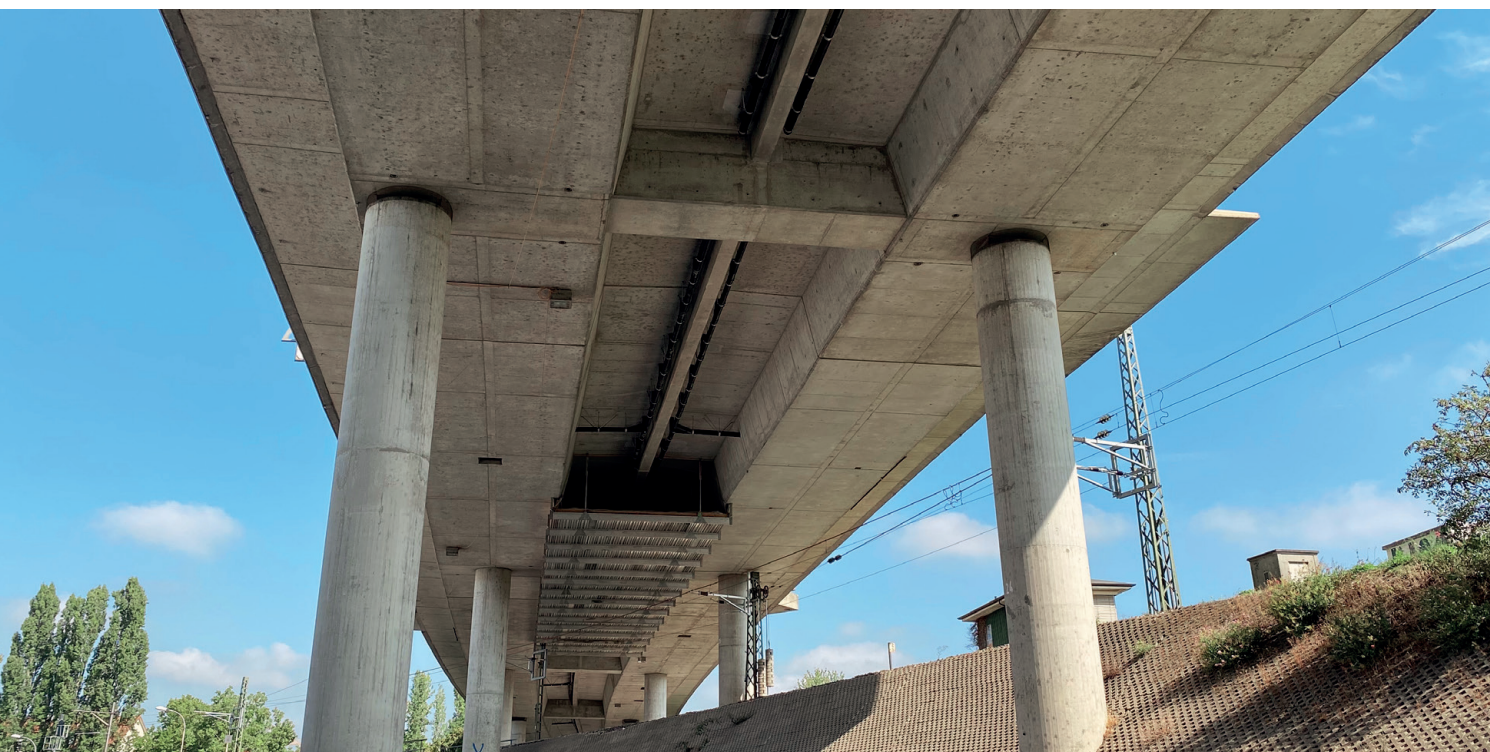
Die Instandsetzung und Verstärkung der Grenzbrücke dauert bis Juli 2023.
